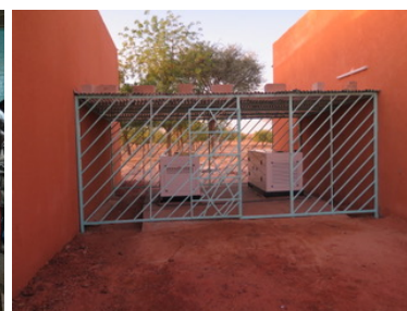
2 Générateurs de secours
