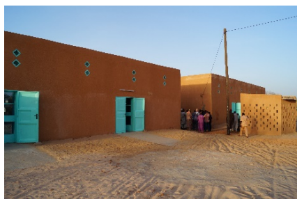
Les deux halls de stockage
